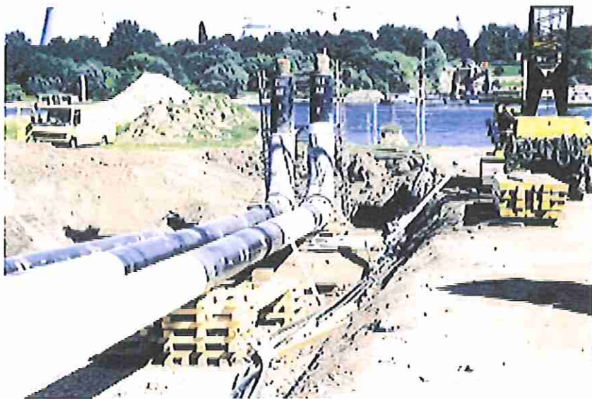
Siphon à Duisburg
