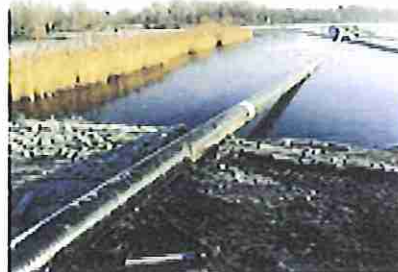
TUBE FW ENVELOPPE ACIER pour le siphon de la rivière Amstel aux Pays-Bas
